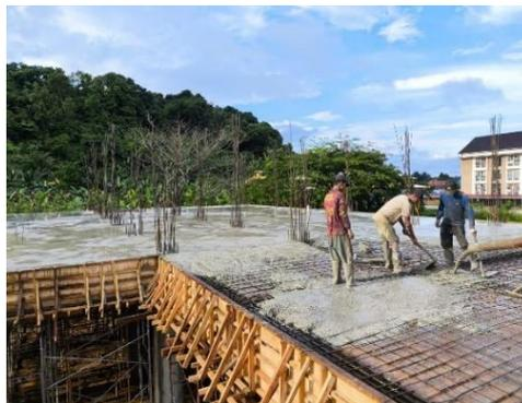
Gambar 7. Pengerjaan Pengecoran Balok
