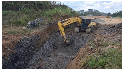
Gambar 2. Pekerjaan Persiapan dan Tanah Dasar
