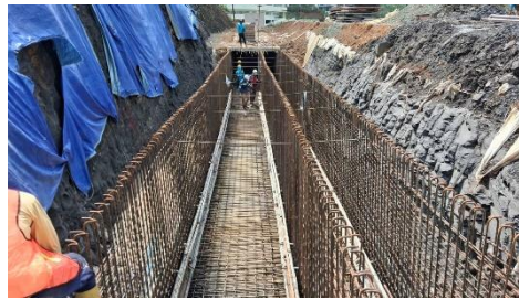
Gambar 3. Pekerjaan Pembesian
