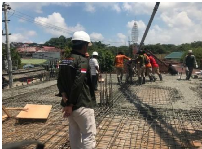
Gambar 7. Pengecoran dengan Menggunakan Concrete pump
