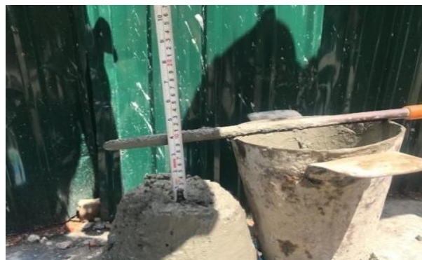
Gambar 4. Uji slump pengecoran Balok dan Plat Lantai Tahap 1
