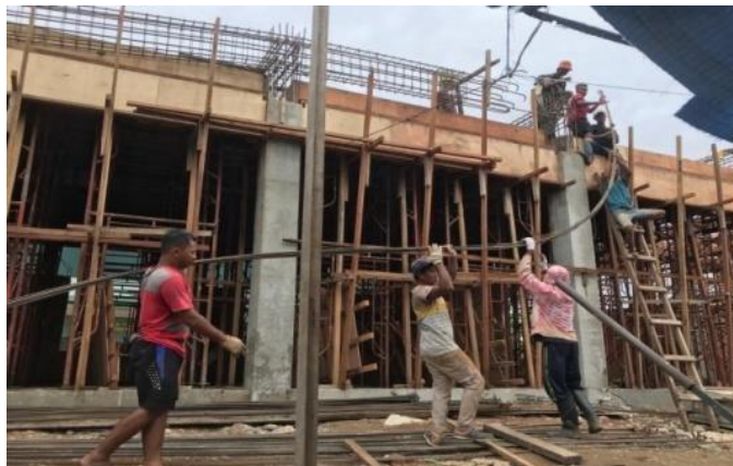
Gambar 1. Pekerjaan Persiapan pada proyek pembangunan mess korem awang long
