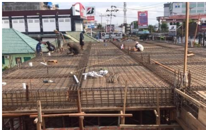
Gambar 3. Proses pekerjaan penulangan plat lantai
