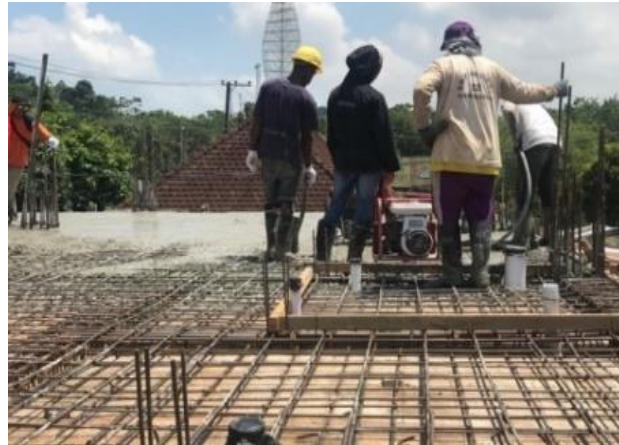
Gambar 8. Penggunaan Concrete vibrator
