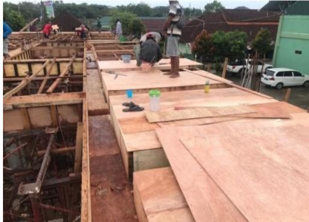
Gambar 2. Pemasangan Bekisting Plat Lantai
