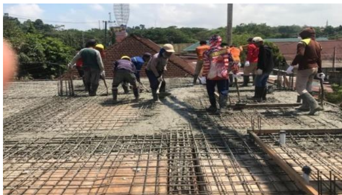
Gambar 9. Proses perataan adukan beton dengan menggunakan kayu perata
