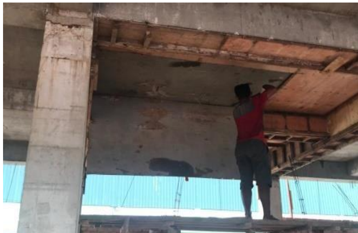
Gambar 11. Proses Pelepasan Bekisting Plat Lantai
