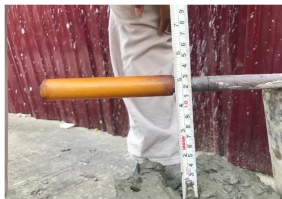
Gambar 5. Hasil Uji Slump pengecoran Balok, Plat dan Kolom Tahap 2
