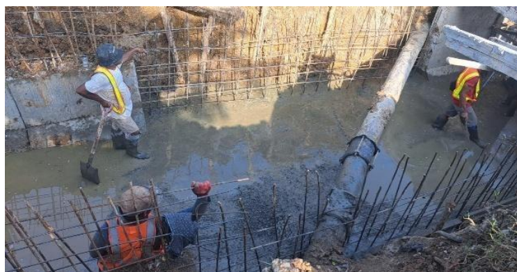
Gambar 9. Pengecoran Lantai Drainase
