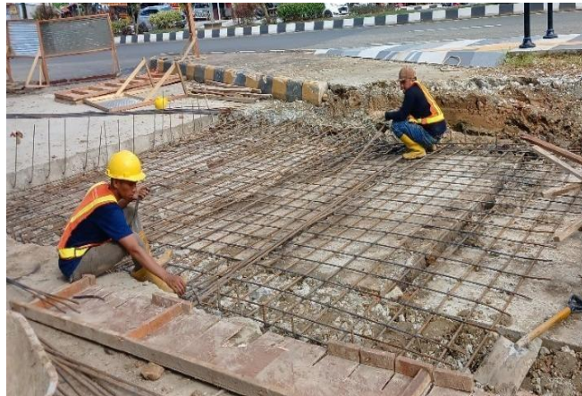
Gambar 4. Pembesian Slab Pada Box culvert
