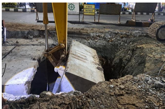
Gambar 3. Proses Pemasangan Box Culvert
