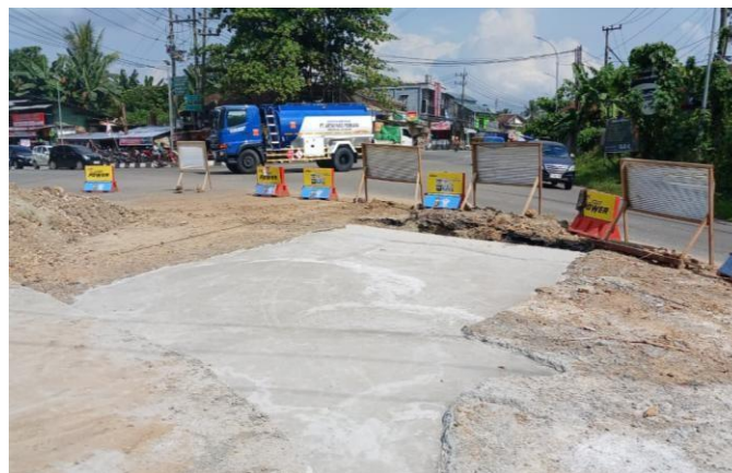
Gambar 7. Pengecoran Jalan Crossing Segmen 2
