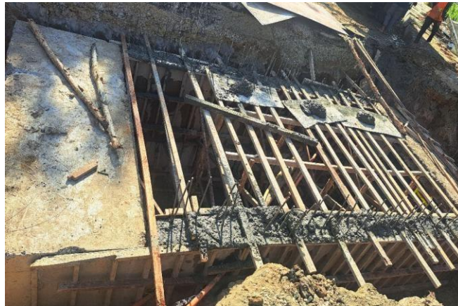
Gambar 6. Pembesian Slab Pada Box culvert
