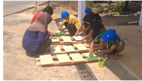
Gambar 6, Pengecatan triplek dan kayu menggunakan cat minyak
