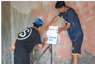
Gambar 7, Pengecatan nama jalan pada Triple
