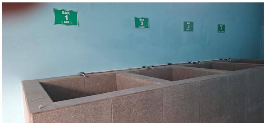
Gambar 4 Bak pembilasan dan disinfeksi plastik plabot infus
