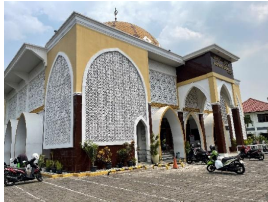
Gambar 1. Kondisi eksterior masjid setelah proses renovasi
